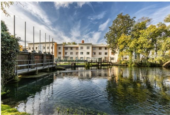
Chiusa canale Amman
